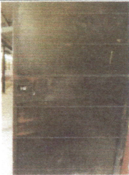
Foto 7: MODULO 6: SUSTITUCION DE PUERTAS DE METAL DAÑADAS
