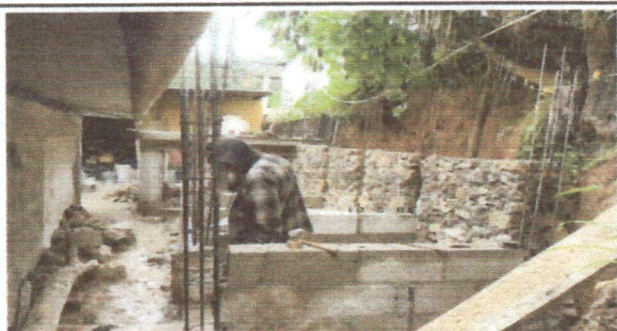
Foto 5: MODULO 4: SEGUIMIENTO DE MÓDULO DE BAÑO
