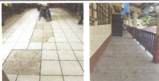
Foto 6: MODULO 6: REPARACION DE PISO DAÑADO Y COLOCACION DE PISO EN PATIOS DE EDIFICIO DE DOS NIVELES
