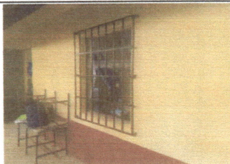
Foto 3: MODULO 2: MEJORAMIENTO Y SEGUIMIENTO PAREDES DE LA DIRECCION
